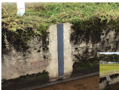
現場打ち水路
