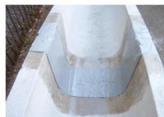
⑫ 完 成 塗料が乾かないうちに 養生テープを剥がす。 膜厚が薄い箇所がないか 確認する。
