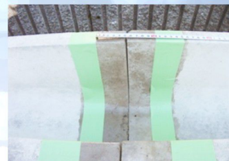
④ 下塗り後 所定の塗り幅で養生テープ を貼る。
