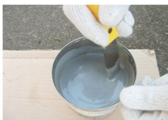
⑦ 反応が始まるので 缶底の隅まで2～3分 しっかり混ぜる。
