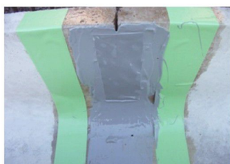
⑩ 1回目塗布後、補強用 繊維を張り付ける。
