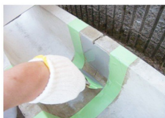
⑨ ゴムベラで1回目塗布。
