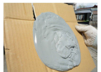
⑧ 段ボールに塗料をあけ 垂直にし塗料が垂れなく なるまで待つ。 (約5分前後)
