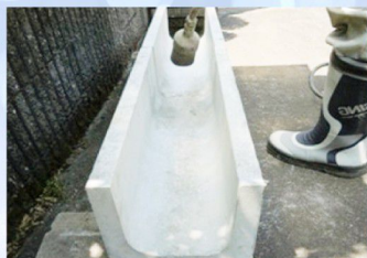
② 下地処理 乾燥 ガスバーナーで乾燥する。
