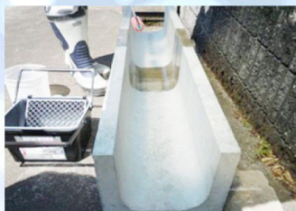
③ 下塗り ミゼロンシーラーU-60を ローラーで塗布。
