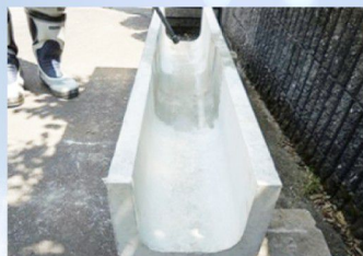
① 下地処理 洗浄 高圧洗浄機で洗浄する。
