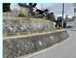
漏水が止まり 路面が乾いています
